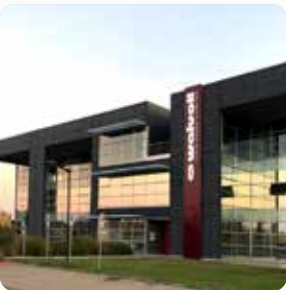
Galtech Site Cavriago (RE) • Italy
