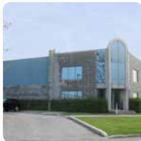
Galtech Canada Inc. Terrebonne • Kanada - Canada
